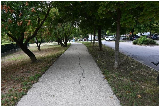
72. kép: Patkó utcai kerékpárút előregedett aszfalt burkolata.
