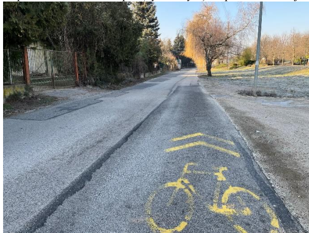
2. kép: Rossz burkolatállapot (nyomvályú!), kopott burkolati jel.
