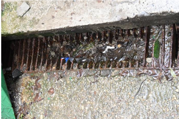
158.kép: Tönkrement vízelvezető rendszer.
