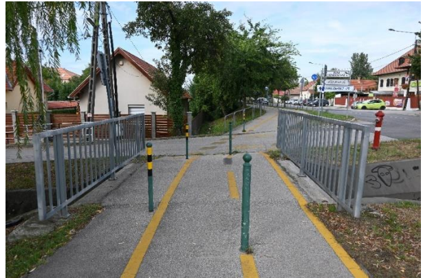
39. kép: Baross u.: balesetveszélyes poller elbontása szükséges.
