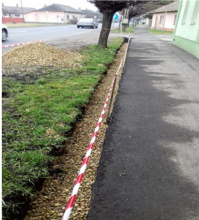
Fő út, (dréncsöves vízvezető rendszer építése)
