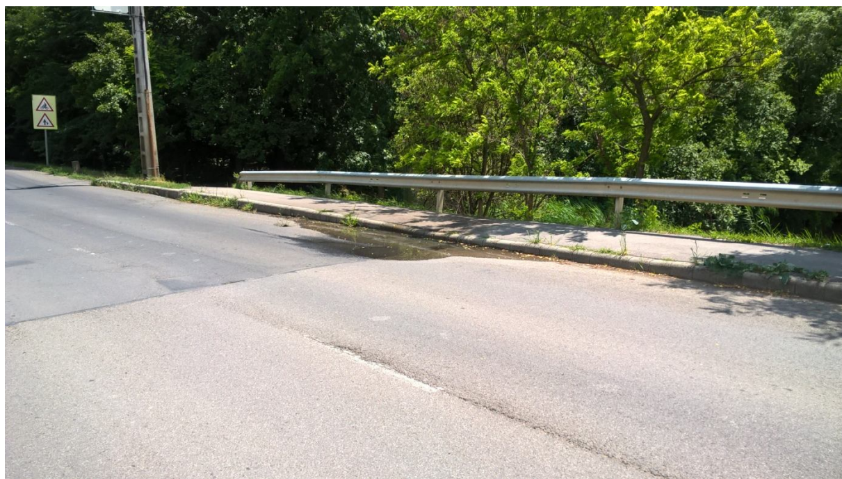
Csőtörés a gyomai hídon.
